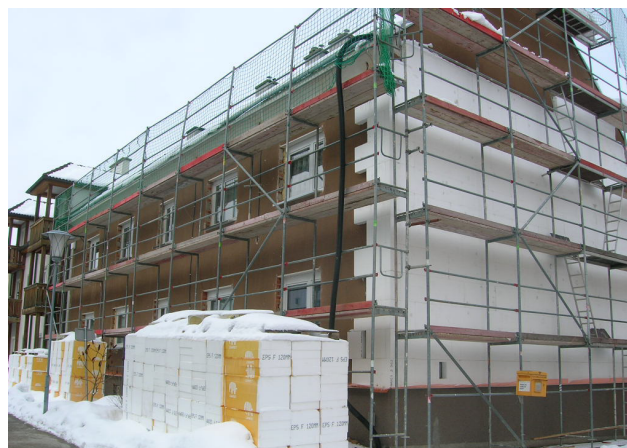
Dämmung mit Polystyrol-Hartschaum Platten (EPS)
