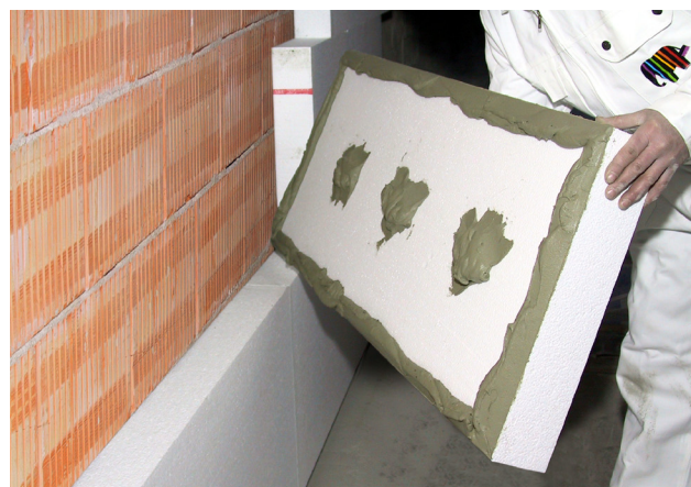
Montage mit Klebemörtel in Randwulst-Punkt-Methode Foto: Capatect
