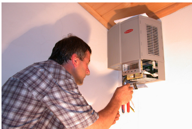
Montage Wechselrichter, Foto "die umweltberatung"
